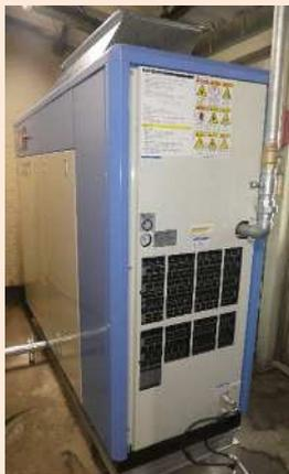
コンプレッサーを大型1台から中型2台に更新しました。インバータ制御と台数制御により低負荷でも、省エネ効果が高い運転ができます。
